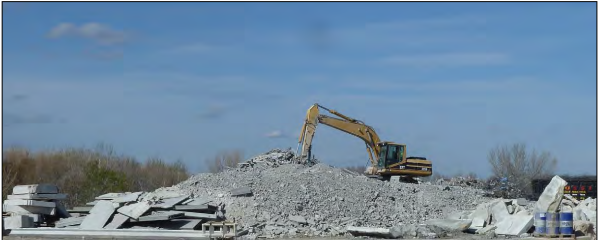
1 – En arrière de la photo : aire de réception– Déferrailage à l'aide de la pelle à pince 2 – En avant de la photo : zone stockage béton en attente de concassage
