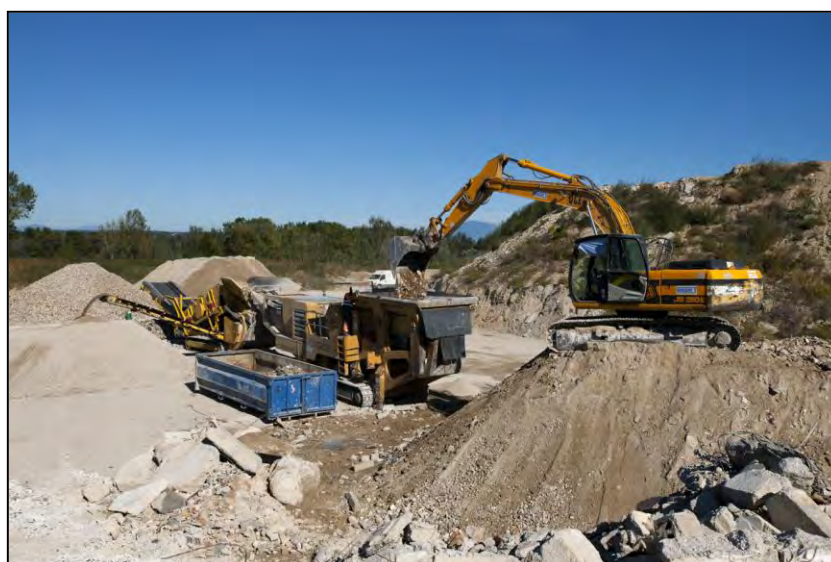
2 – Atelier de préparation des gravats non terreux
