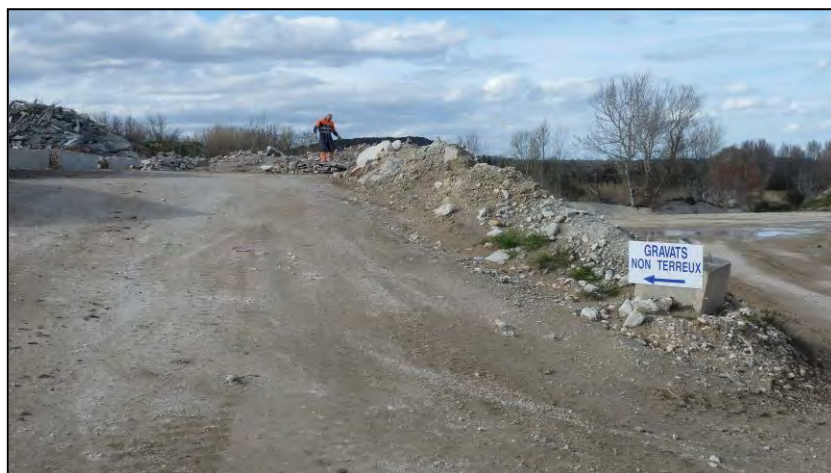
1 - Aire de réception des gravats non terreux
