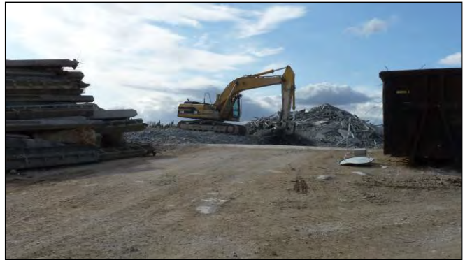
1 - Aire de réception – Déferrailage à l'aide de la pelle à pince
